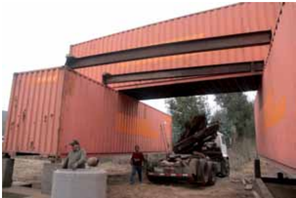
Montaje de los contenedores que conforman la estructura exterior del taller y almacén.
